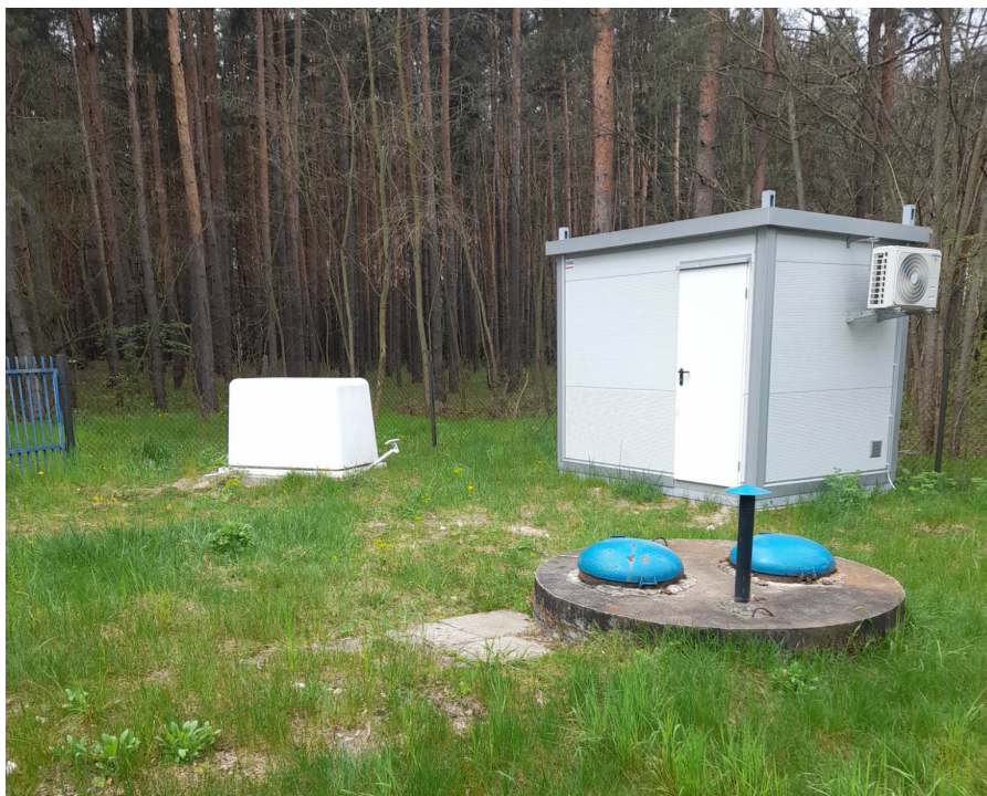
Fot. 1 – Ujęcie wody w Zagajowie z widoczną studnią zasadniczą S-1, awaryjną S-2 oraz budynkiem kontenerowym - sterownią.
